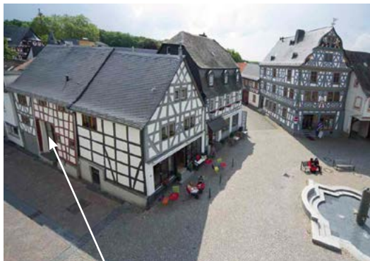
Das kleine Übergangs-Büro am Bad Camberger Marktplatz.
